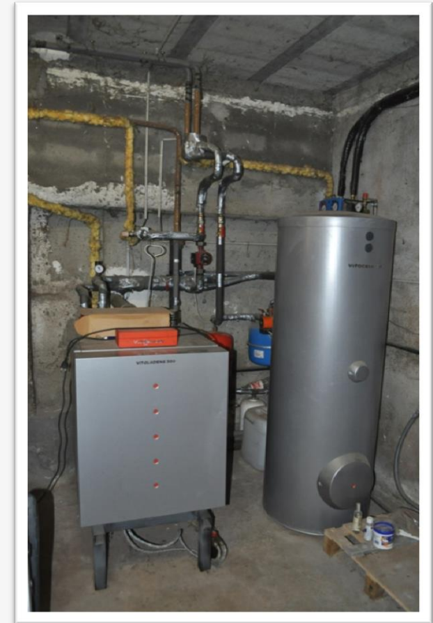
Chaudière fuel à condensation, Source Ajena
