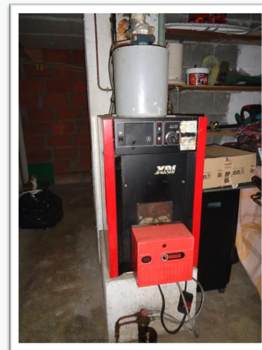
Chaudière ancienne, Source Ajena
