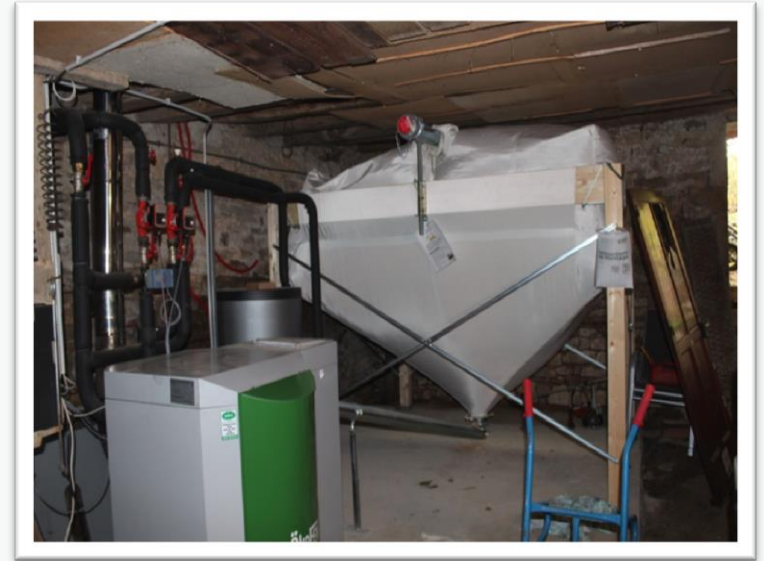
Chaudière à granulés et silo, Source Effilogis
