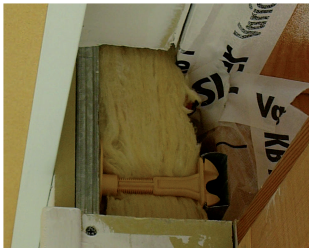
Figure 20 : structure de doublage intérieure à faible pont thermique structurel.
