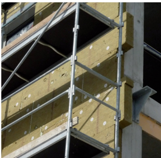
Figure 23 : cheville fixant un isolant sous enduit.
