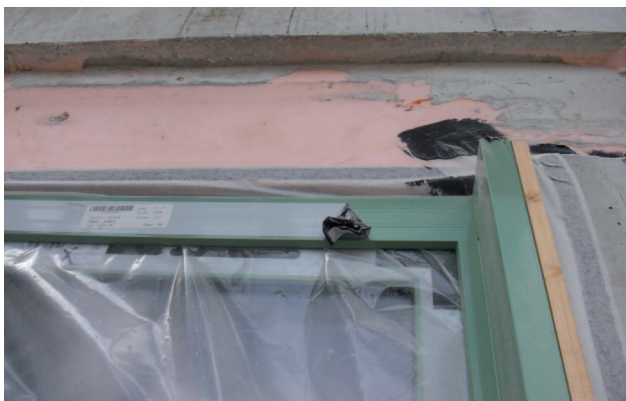
Figure 19 : isolant en réservation derrière un coffret extérieur de volet roulant.
