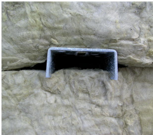
Figure 22 : profil métallique support de bardage créant une lame d'air.
