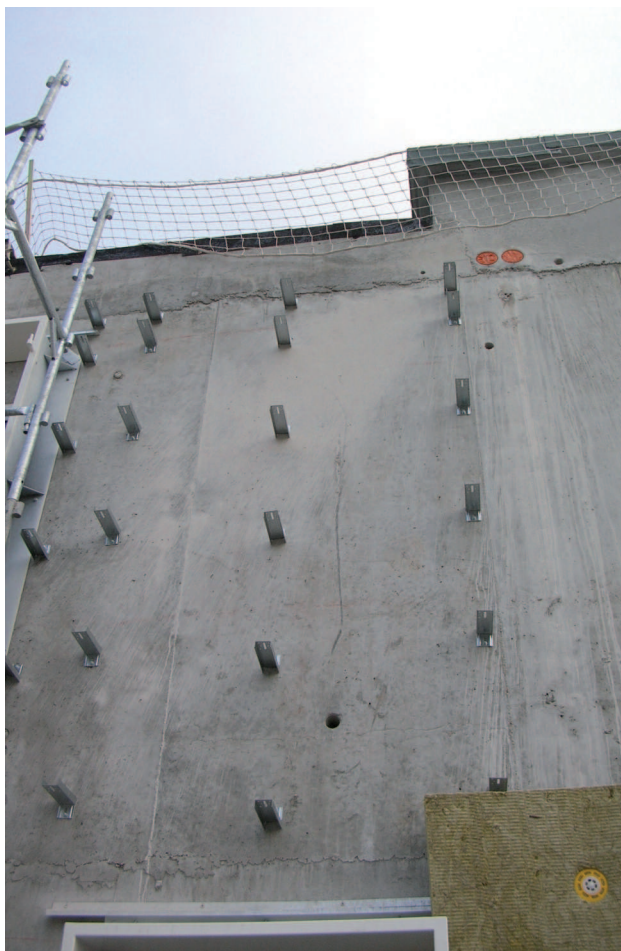
Figure 21 : équerres métalliques support de bardage.
