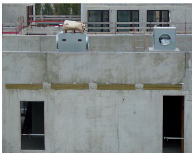
Figure 17 : acrotère partiellement désolidarisé.
