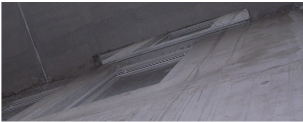
Figure 12 : balcon partiellement désolidarisé.
