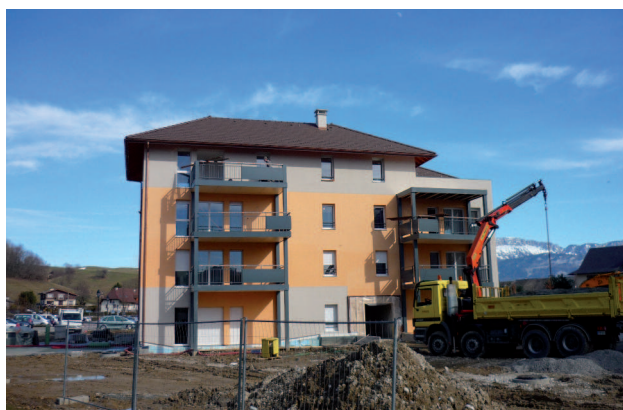
Figure 15 : balcon totalement désolidarisé (ou autoporté).
