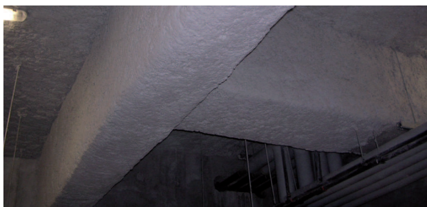
Figure 10 : isolation de poutres sur leurs trois faces.
