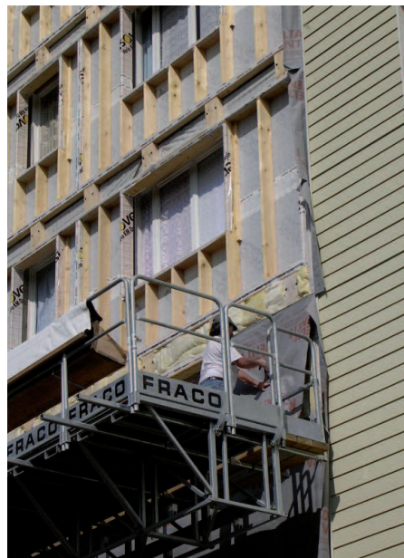
Figure 24 : isolation extérieure sur ossature bois (en rénovation).
