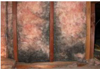
Isolant dégradé par l'humidité
