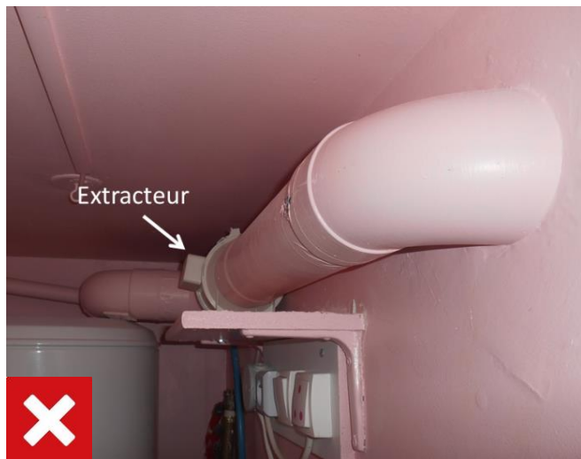
Extracteur positionné à l'intérieur du bâtiment ©AQC/RBBD
