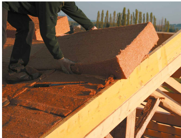
Isolation « sarking » avec une laine de bois.
