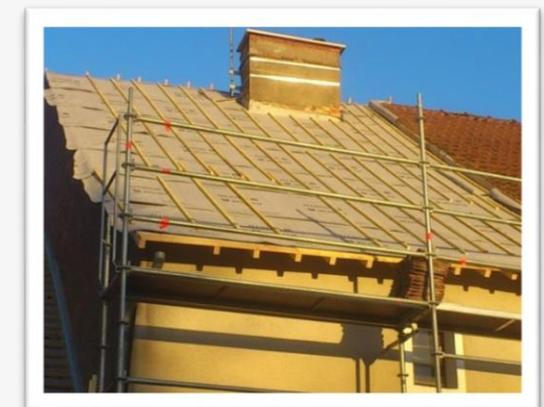
Pose d'un écran de sous-toiture HPV, Source Ajena
