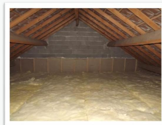
Isolation par rouleaux en combles perdus avec traitement du pont thermique du mur de refend, Source Effilogis
