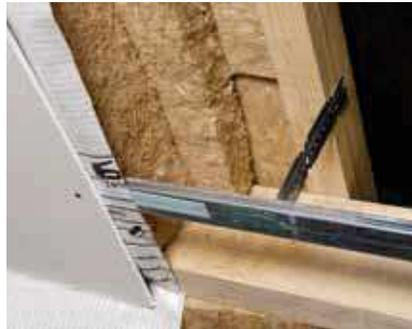
b) Suspente + fourrure + membrane (pas de vide technique) + parement
