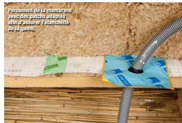
Percement de la membrane avec des patchs adaptés afin d'assurer l'étanchéité de la gaine.
