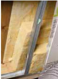
a) Rail M48 + membrane (pas de vide technique) + parement
