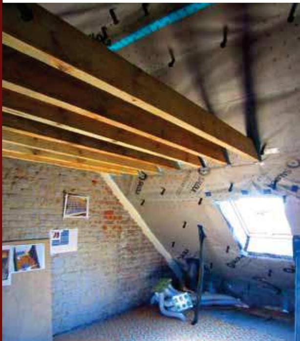
Mise en étanchéité parfaite entre les fenêtres de toit, les poutres mezzanine, les murs et autres passages de gaines (solaire thermique, VMC)
