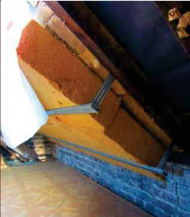
Mise en place de laine de bois (confort d'été), avec fourrure + suspente métallique, 8 cm entre chevrons + 16 cm en croisé... mais ce n'est pas fini !
