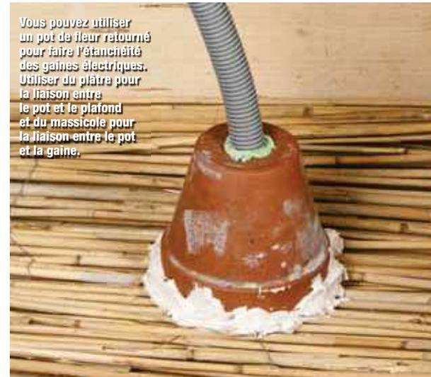
Vous pouvez utiliser un pot de fleur retourné pour faire l'étanchéité des gaines électriques. Utiliser du plâtre pour la liaison entre le pot et le plafond et du massicoles pour la liaison entre le pot et la gaine.
