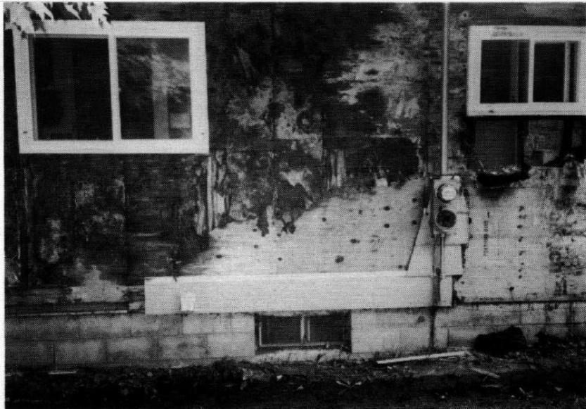
Figure 21 : Exemple de dommages dus à la condensation. Source : TenWolde et Rose
