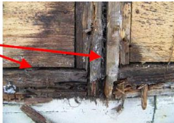
Figure 44 : Dommages sur une construction bois liés à des exfiltrations d'air Contacté pour des explications complémentaires sur ce document, il ajoute :
