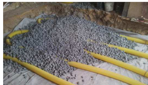
Figure 20 - mise en place du drain d'air
