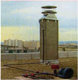
Exemple de conduit d'évacuation vertical avec extracteur Source : Outilsolaires
