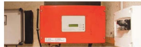
Le choix d'onduleurs n'est pas très vaste et la plupart des modèles n'ont pas été spécifiquement développés pour les petites éoliennes: en découlent parfois quelques problèmes techniques. La mise au point d'onduleurs spécifiques constitue donc un axe de recherche et développement important. Leur durée de vie est généralement d'une dizaine d'années, contre vingt ans pour les autres constituants de l'éolienne, hors pièces d'usure.
