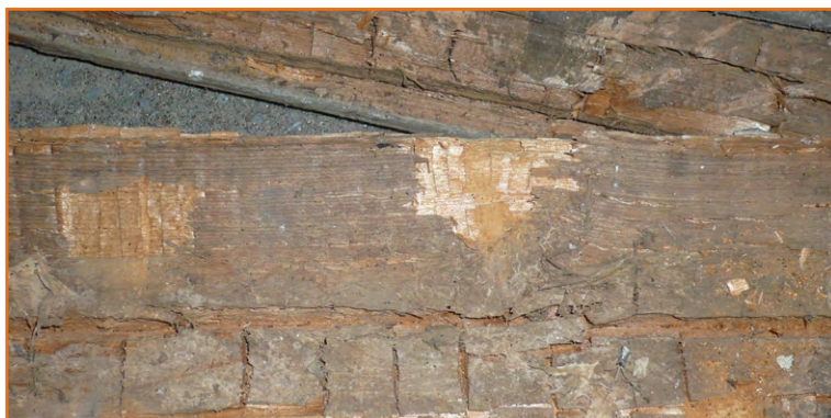
Planche « méréée » qui a perdu ses propriétés mécaniques.
