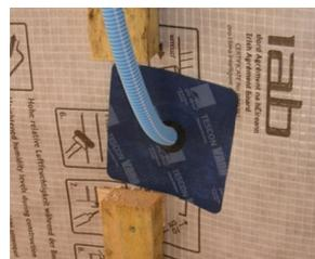
Dans certains cas, la traverser de la paroi étanche sera nécessaire (ex: point électrique extérieur). Il existe pour cela des scotchs adaptés au passages de gaines électriques.
