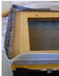
Dans le cas de pose de menuiseries en tunnel (encastré dans la maçonnerie), une « jupe d'étanchéité » permet de faciliter la liaison entre la fenêtre et la membrane pare-vapeur.
