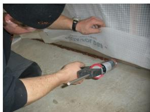
La membrane peut aussi être collée sur un élément maçonné. La dalle béton par exemple, assure dans certains cas l'étanchéité à l'air.
