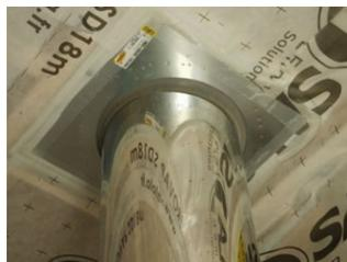
Pour la traversée de la membrane par un conduit de fumée, une plaque de sécurité permet de conserver les distance de sécurité vis-à-vis du conduit tout en conservant une étanchéité à l'air.
