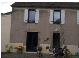
Maison en pierre avec enduit chaux en partie basse (Dossier Tiner-gie 181115)
