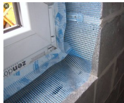
Jupe d'étanchéité et mousse pré-imprégnée pour les menuiseries
